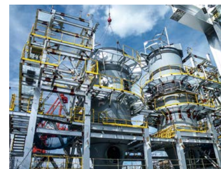
プラント据付工事
